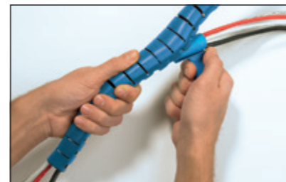
Placera appliceringsvertyget i en av ändarna på Helawrap.
