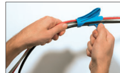
Lägg i en eller fler kablar i appliceringsvertyget.
