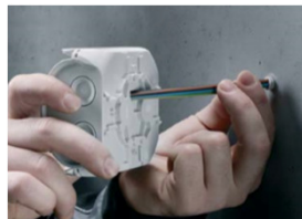
Kabelgenomföring i botten via ett elastiskt membran i DK-serien .
