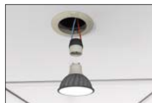
3. Anslut ljuskällan till sockeln och fäst i korrekt position.
