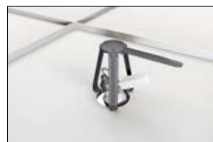
3. Installera din Led-spot.
