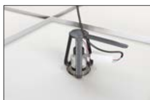
4. Anslut och fixera kabeln i kabelhållaren.
