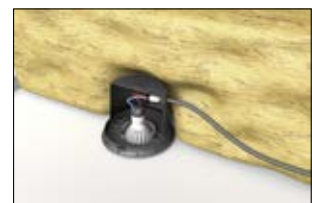
4. Isoleringen kan nu appliceras.
