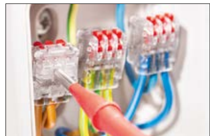
Testhål på undersidan av toppklämman.
