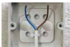
Dragavlastning med ett buntband i botten
