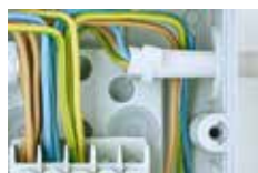
Dragavlastning med ett buntband i botten
