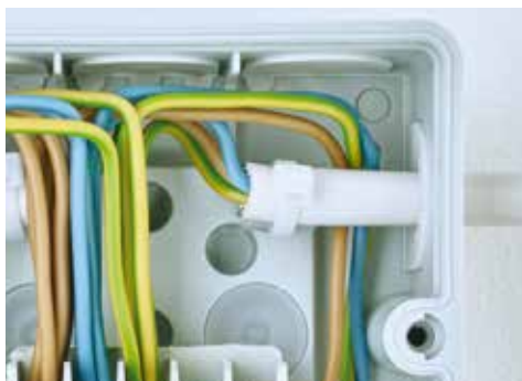
■ Dragavlastning med ett buntband i botten
