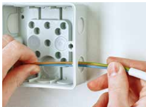
■ Ingen håltagning behövs – stick in ledaren så är det klart.
