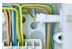
Dragavlastning med ett buntband i botten
