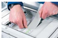
Utskurna kåpor för undvikande av direkt kontakt med farliga strömförande delar
