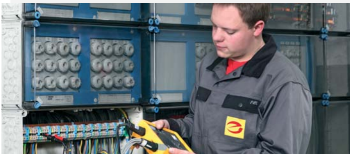
Fördelning upp till 630 A som kopplings- och styrningsutrustning (PSC) i enlighet med IEC 61 439 del 2
