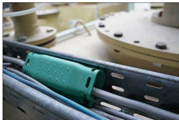
Installerad gelskarv Relifix V.
