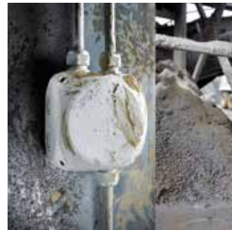
KF-serien: IP 66/IP 67/IP 69 väderbeständig, för oskyddad installation utomhus metrisk utbrytningsöppningar
