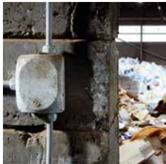
DK-serien: IP 66 för skyddad installation elastiska membran eller metrisk utbrytningsöppningar
